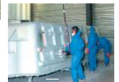
Pose des renforts + résine de protection
