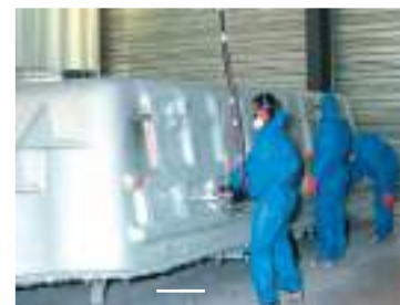
Pose des renforts + résine de protection
