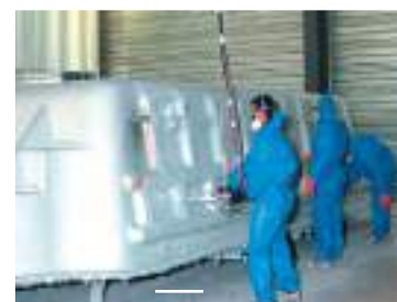
Pose des renforts + résine de protection
