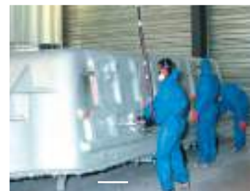
Pose des renforts + résine de protection
