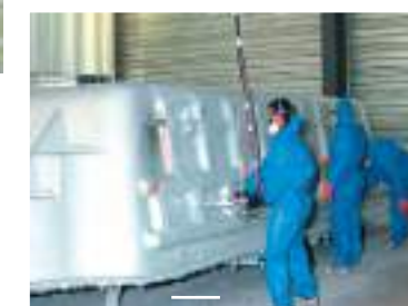
Pose des renforts + résine de protection
